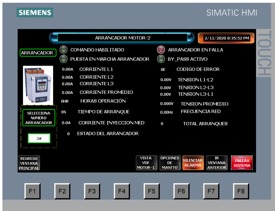
Figura 7.0 vista de estado del sistema. Muestra el estado del motor activado, modo de operación fallas registradas, incluyendo estado básico del arrancador.
