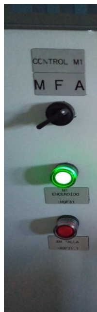
Figura 2.1 Muestra de forma física el indicador piloto en el botón de arranque, que el motor-1 está en forma activo.
