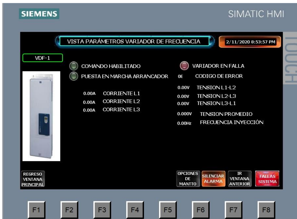
Figura 7.1 Vista de los parámetros eléctricos del variador de frecuencia.
